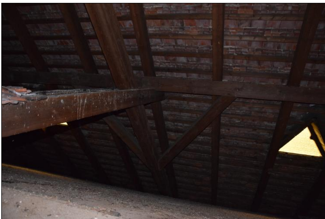
Fot.8 Więźba kościoła
