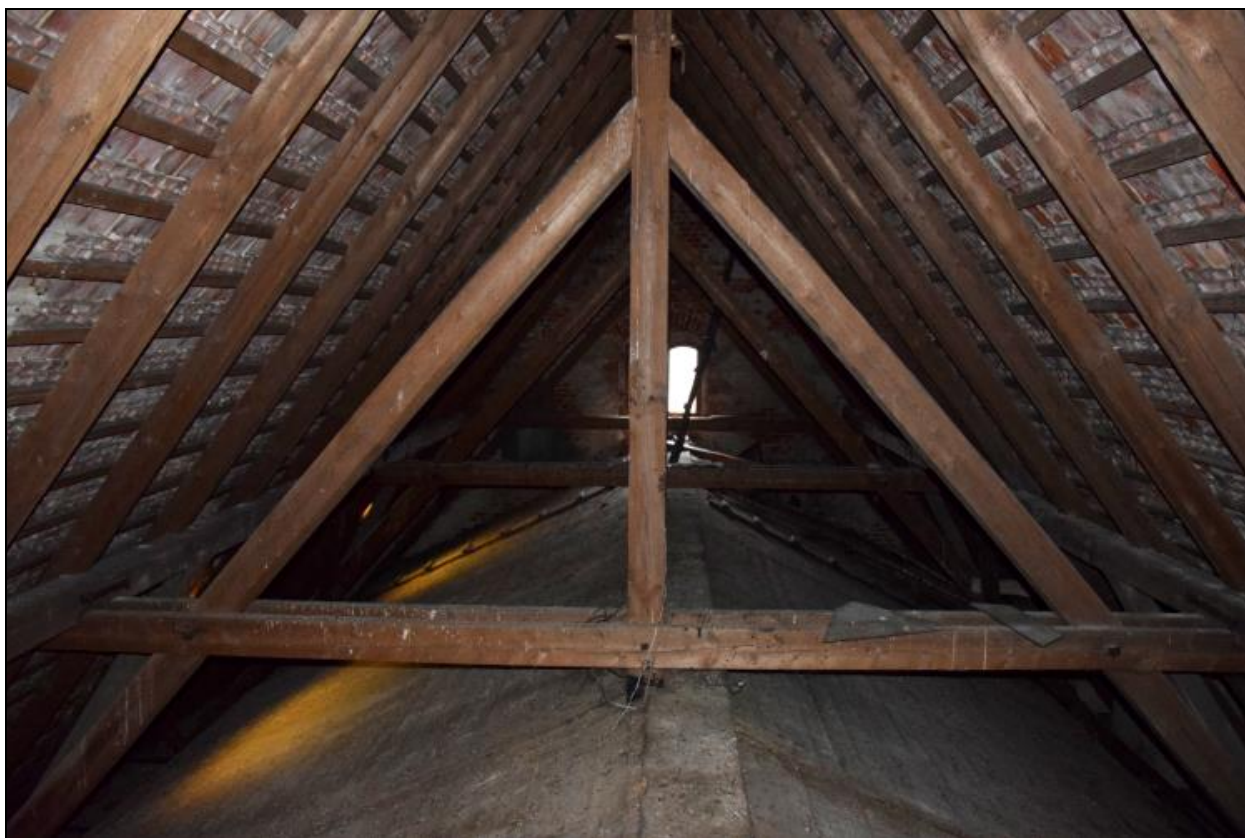
Fot.7 Więźba kościoła – wiązar pełny
