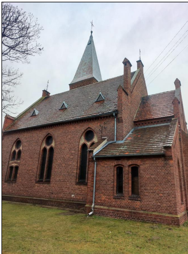
Fot.1 Elewacja południowa
